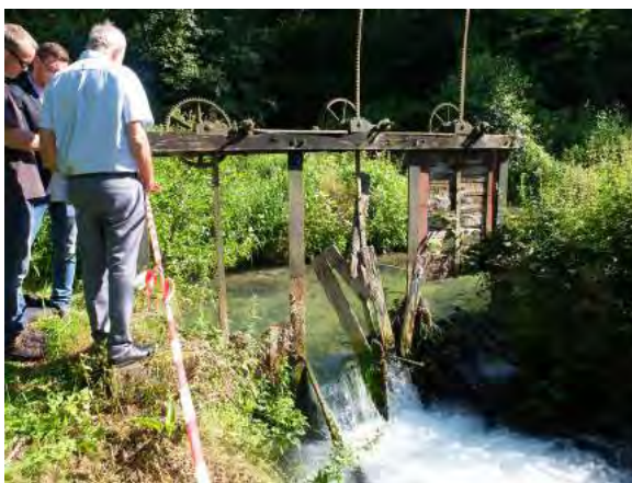
Vestige de vannes - Photo Source DM
