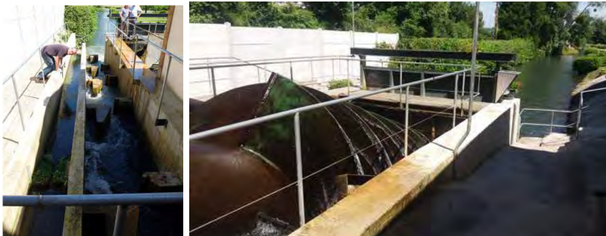
L'usine principale, avec de gauche à droite : passe à anguilles, passe à bassins multi-espèces, vis d'Archimède (ichthyocompatible)
